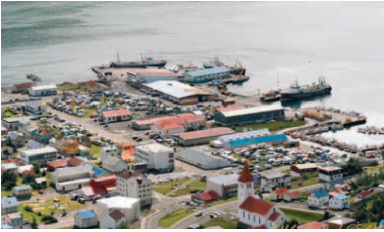
Í byrjun 20. aldar var á Siglufirði lítið þorp, hálfvorskt, sem óx svo hratt að Siglufjörður öðlaðist kaupstaðarréttindi árið 1918 og varð um leið sjálfstætt lögsagnarumdæmi. Um miðja öldina var staðurinn orðinn einn af stærstu kaupstöðum landsins.
