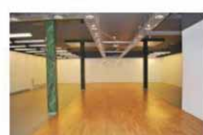
Rými F: Skrifstofu- og lagerhúsnæði á jarðhæð, 390 fm. Hentar einnig sem sýningarsalur. Möguleiki á að opna á milli rýma F og E.
