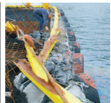
SKEMMDIR Nýr bryggjukantur brotnaði og skemmd varð á stálþili. Tjónið getur numið nokkrum milljónum króna.
