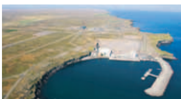
HELGVÍK Norðurál Helgvík sf. fékk byggingarleyfi frá Reykjanesbæ og Garði.
