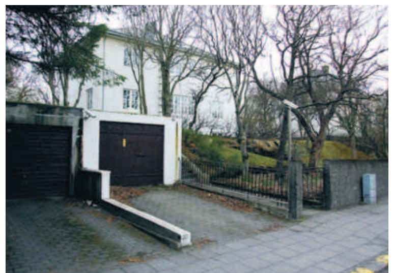
LAUFÁSVEGUR Ágreiningi um stækkun hússins á Laufásvegi 73 um 278 fermetra virðist lokið með samþykkt byggingarleyfis.
