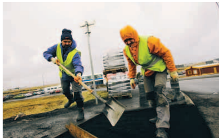
ERLENT VINNUAFL Verkamenn frá Slóvakíu helluleggja við Hringbraut árið 2006.
