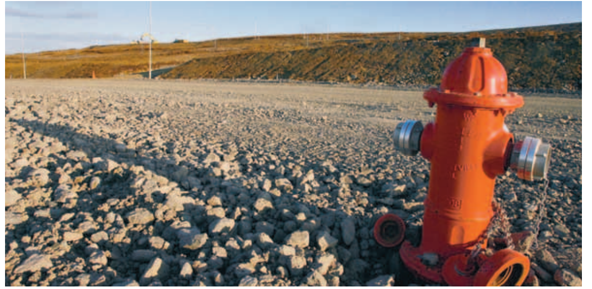
HÚSLAUS GATA VIÐ URRÍÐAVATN Fjölmörgum lóðum hefur verið skilað til sveitarfélaga á undanförunum mánuðum. Um 9.000 íbúðir eru í byggingu á höfuðborgarsvæðinu.
