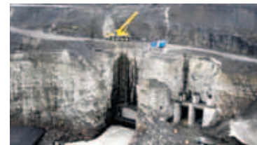
VIRKJUN Landsvirkjun hefur tekið að sér lokafrágang við vinnubúðir Impregilo.
