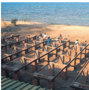
VIÐ MALAVÍVATN Nýja fiskverkunaraðstaðan í Madzede.
