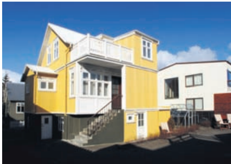
Gamla húsið á Grettisgötunni er reisulegt en það var byggt árið 1904. Þegar mest var bjuggu 24 manneskjur í húsinu sem er um 184 fermetrar á þremur hæðum.
