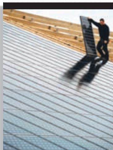
SÓLARORKA Verkamaður leggur hluta af risavöxnum sólarcellum í Weinbourgh í Frakklandi. Sólarcellurnar verða um 36 þúsund fermetrar, sem samsvarar sjö fótboltavöllum. Þær munu safna um 4,5 megavöttum af orku á ári. NORDICPHOTOS/AFP
