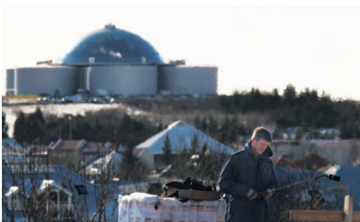
DYTTAÐ AÐ HÚSI GUÐS Endurbætur standa nú yfir á kirkjubyggingu Óháða safnaðarins við Háteigsveg í Reykjavík. Sólin sklein ríkulega á viðgerðarmenn og í fjarska blasti Perlan við ofan af húspakinu. FRÉTTABLAÐIÐ/ANTON
