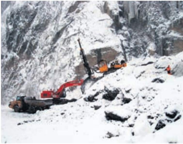
Í Dimmugljúfrum er Ístak með verkefni á vegum Landsvirkjunar. Það snýst um að útbúa hyl undir 90 metra háum fossi sem fellur fram af Kárahnjúkastifflunni á yfirfalli.
