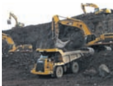
Framkvæmdir ganga samkvæmt áætlun. Reiknað er með að verkinu ljúki 2010.
