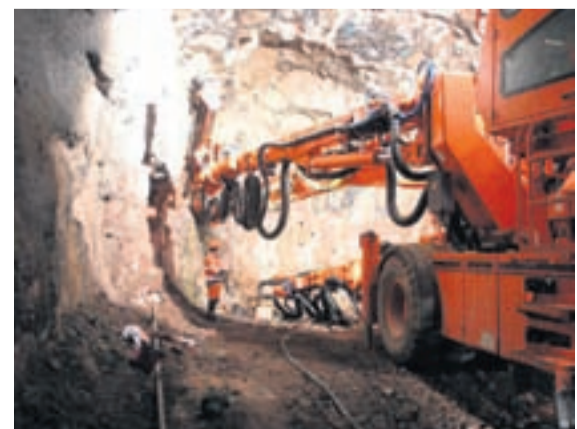
Borað í Héðinsfjarðargöngum.
