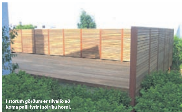
Enfaldleiki einkennir hönnun veggjanna og efniviðurinn, gagnvarinn fura, hentar vel íslensku veðurfari.
