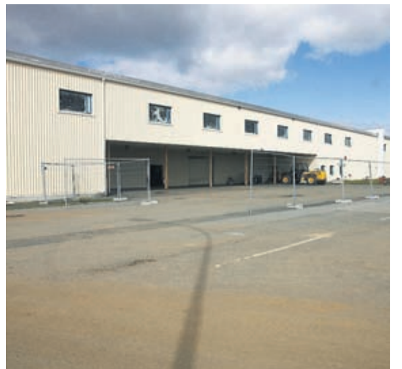
SKEMMUR VERÐA NETÞJÓNABÚ Búið er að rífa allt innan úr tveimur gömlum skemmum. Íslenskir aðalverktakar sjá um framkvæmdirnar fyrir íslensk-bandaríska fyrirtækið Verne Holding.
