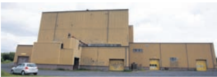
TOPPSTÖÐIN Landsvirkjun hefur gefið heimild fyrir tímabundin afnot af byggingu varaflostöðvar í Elliðaárdal.
