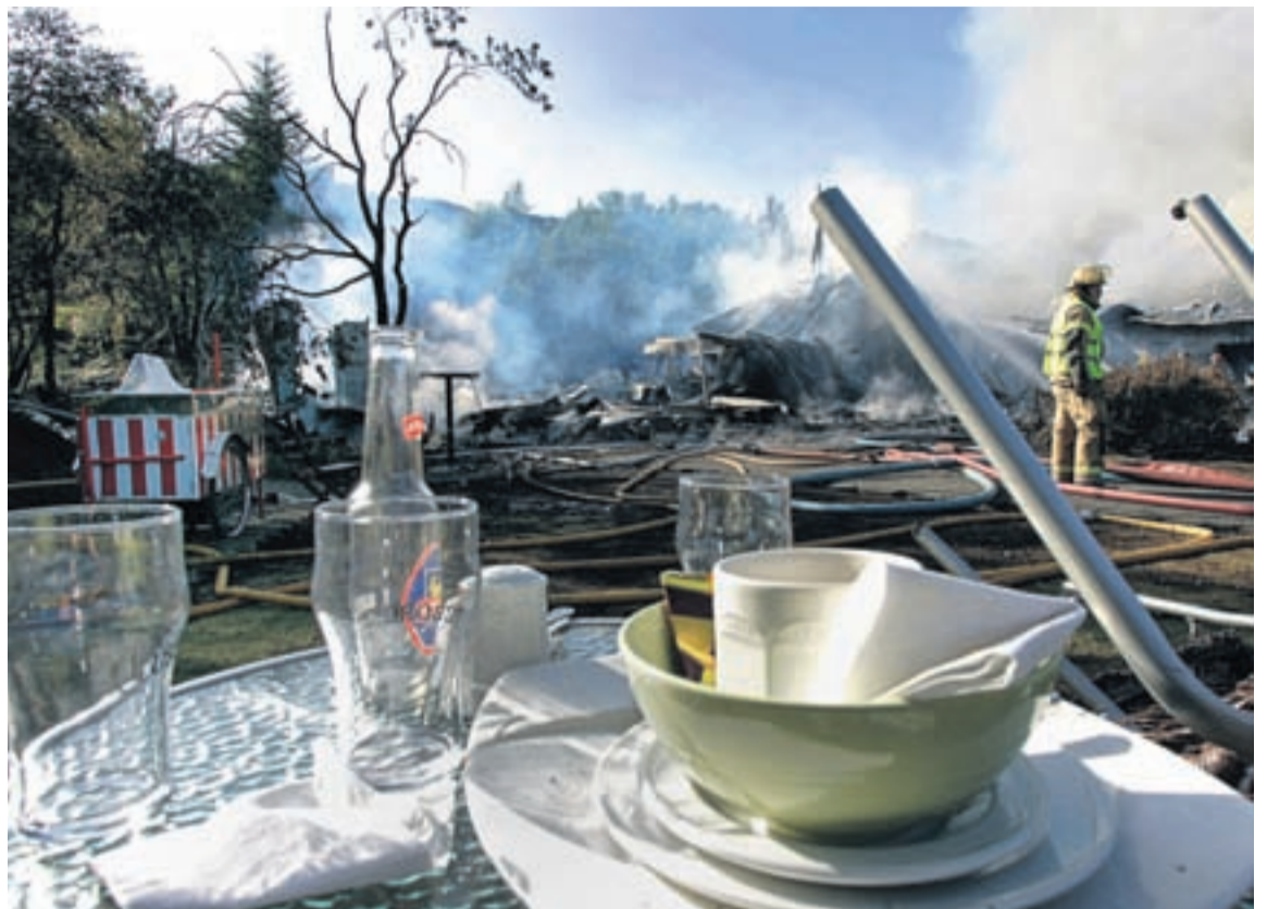
RÚSTIR EINAR Skelfileg sjón blasir við þar sem Hótel Valhöll stóð áður eftir eldsvoða í gær. Eldur varð laus í húsinu síðdegis í gær og varð húsið alelda á um hálfri klukkustund. Eldurinn kviknaði á fimmta tímanum og sat fólk að snæðingi í borðsalnum þegar eldurinn kom upp í eldhúsi hótelsins.
