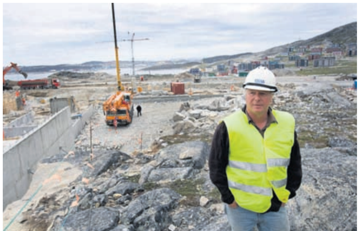
Á BYGGINGASVÆÐINU Theodór er verkstjóri á svæðinu, þar sem tæplega þrjátíu manns vinna við byggingu skóla.
