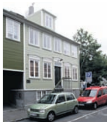
Húsið að Þingholtsstræti 7 er frá árinu 1880. „Nýr eigandi ætlaði að skipta um bárujárn og þá komu í ljós merki eftir mjög fallega gluggaumgjörð sem við köllum bjóra. Þá ákvað eigandinn að fara í uppruna hússins. Húsið var gert mjög fallega upp samkvæmt þeim ummerkjum sem fundust undir járninu.“
