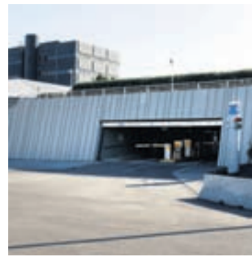
BÍLASTÆÐAHÚS Nú á að skoða hvort bílastæðahús borgarinnar skuli seld til einkaaðila. FRÉTTABLAÐIÐ/GVA
