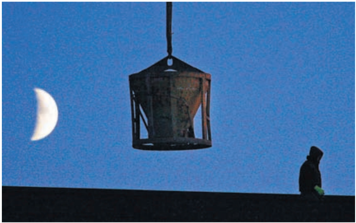
LEGGJA NÓTT VIÐ DAG Byggingarverkamenn sem vinna við að reisa hjúkunarheimili við Suðurlandsbraut verða, eins og aðrir landsmenn, áþreifanlega varir við að dagur styttest jafnt og þétt. Þegar þessi mynd var tekin um eftirmiðdaginn í gær sást stórt handa skil. Vetrarsólstöður eru 22. desember næstkomandi. FRÉTTABLAÐIÐ/PJETUR
