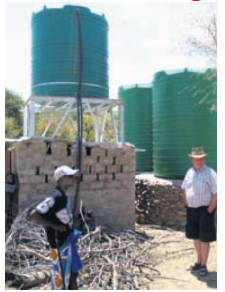
BRUNNUR Vilhjálmur Wium fylgist með hvernig vatni úr brunni er dælt í tanka, en dælan er knúin áfram með sólarorku. MYND/GSAL
