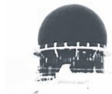
Neyðarskýli og radarstöðvar sem standa af sér öll veður eru búnin til úr trefjaplasti
