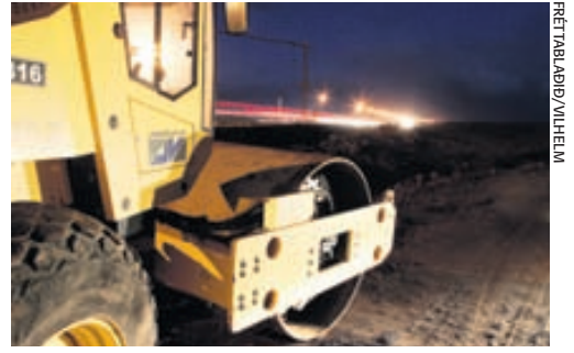
ALLT BÚIÐ Jarðvélar höfðu með höndum vinnu við tvöföldun Reykjanesbrautar, en þegar fyrirtækið komst í þrot stöðvaðist vinnan þar tímabundið.
