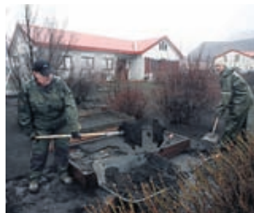
HREINSUNARSTARF Enn er mikið verk óunnið undir Eyjafjöllum.
