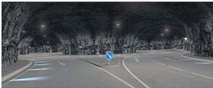
SKÁLAFJARÐARGÖNG Jarðgöng eru víða í Færeijum, en metnaðarfullstu göngin eru væntanlega þessi, sem verið er að undirbúa. Ellefu kílómetrar, þrjú op og hringtorg.
