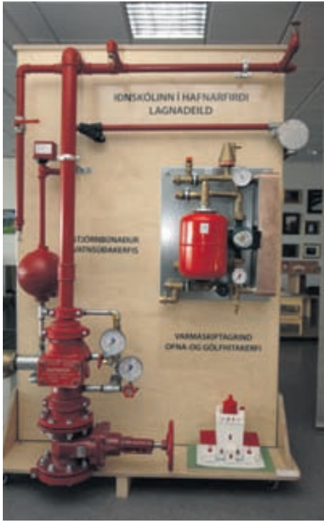
Frá lagnadeild eru vatnsúðakerfi og varmaskiptagrind.
