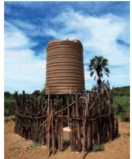
Sólarsellur knýja vatnsdælu sem gengið er frá ofan í borholunni og þaðan fer vatnið í tíu þúsund lítra vatnsgeymi sem hvílir á steypum undirstöðum.
