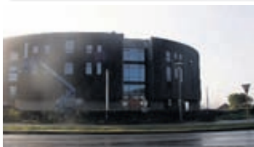
MENNINGARHÚSIÐ HOF Allar sýningar hátíðarinnar fara fram í nýju menningarhúsi Akureyringa. MYND/SUNNA
