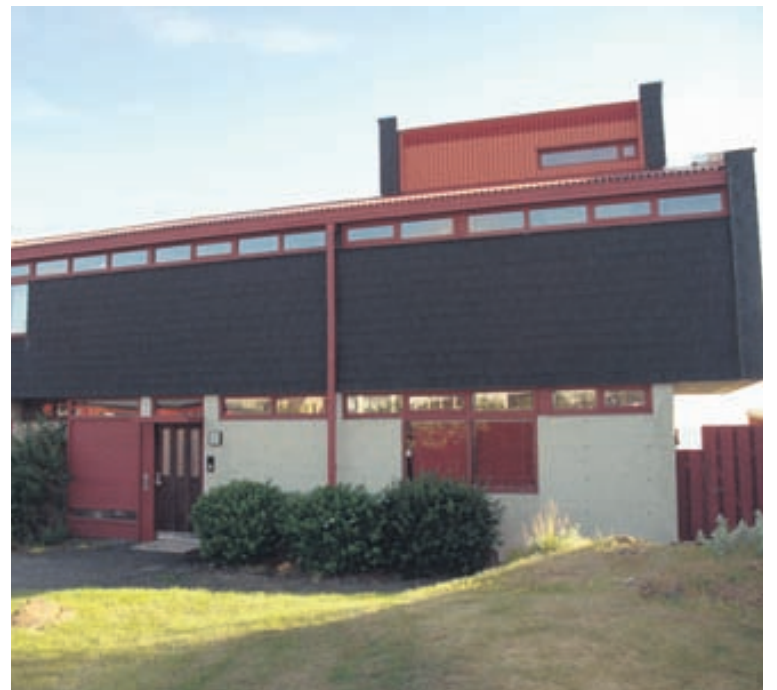
Fallegt útsýni er úr húsinu sem stendur á sjávarlóð á sunnanverðu Seltjarnarnesi.
