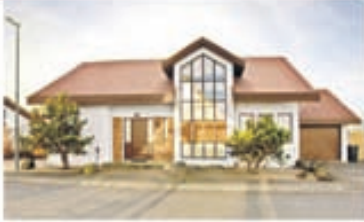
Hálsasel - Einbýlishús 317,4 fm reisulegt einbýlishús með aukaíbúð á jarðhæð og innb. 26 fm bílskúr. Húsið er mjög fallegt sem og lóðin og allt umhverfi. Heitur pottur. Húsið er vel staðsett, innst í lokuðum botnlanga í fjölskylduvænu hverfi. Verð 55 millj. Laus strax!
