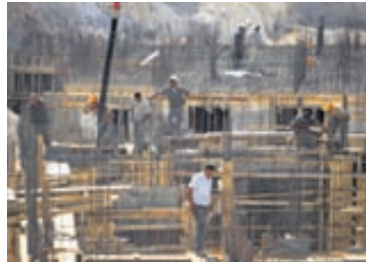
BYGGINGARFRAMKVÆMDIR Í Beitar Illit, byggð ísraelskra landtökumanna á Vesturbakkannum, halda framkvæmdir áfram þrátt fyrir frystingu í Jerúsalem.
