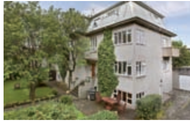
Reynimelur - 3ja herbergja m/bílskúr Mikið endurnýjaða 86,9 fermetra 3ja herbergja íbúð ásamt 33,6 fermetra bílskúr. Íbúðin skiptist í forstofugang, barnaherbergi, hjónaherbergi, stofu, eldhús, baðherbergi, ásamt sérgeymslu í sameign og sameiginlegu þvottahúsi, bílskúr. Nánari uppl. á skrifst.
