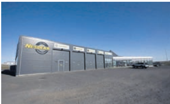
Nesdekk í Reykjanesbæ er á Njarðarbraut 9.
