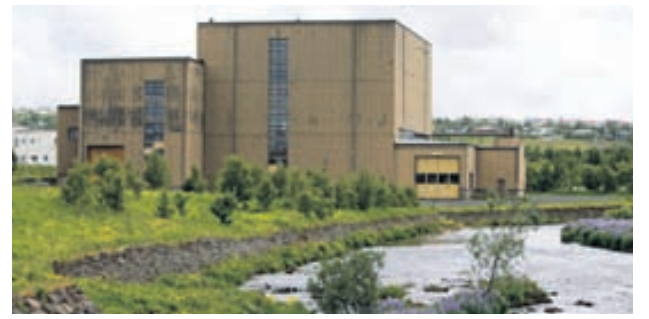
TOPPSTÖÐIN Stöðin er í gömlu varaafsstöðinni í Elliðaárdal.
