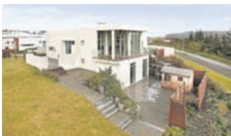
Steyptir skjólveggir eru kringum allt húsið og 250 fermetra upphitað bílplan. Stórar timburverandir úr harðviði eru á lóðinni og stuðlaberg prýðir garðinn.
