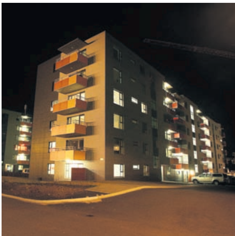
SKIPALÓN 16-20 Fjölbýlishús ætlað fyrir fimmtíu ára og eldri. Maður einn keypti íbúð í húsinu og í henni býr barnsmóðir hans og sautján ára sonur þeirra.
