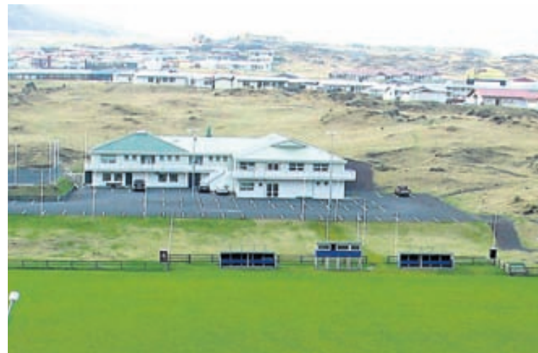
STÚKAN FÆRIST NÆR TÝSHEIMILINU Nýja stúkan í Eyjum er áætluð á þeim stað þar sem varamannabekkir eru í dag.
