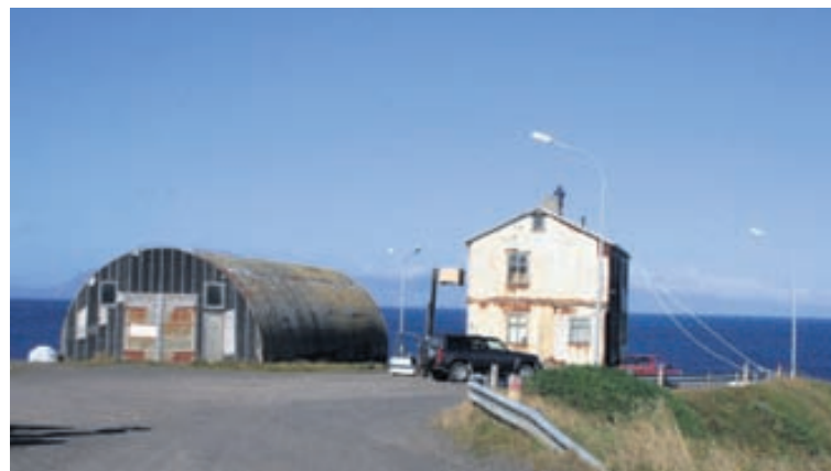
Halldórshús, eða gamla kaupfélagshúsið, verður glæsilegt þegar viðgerð lýkur.
