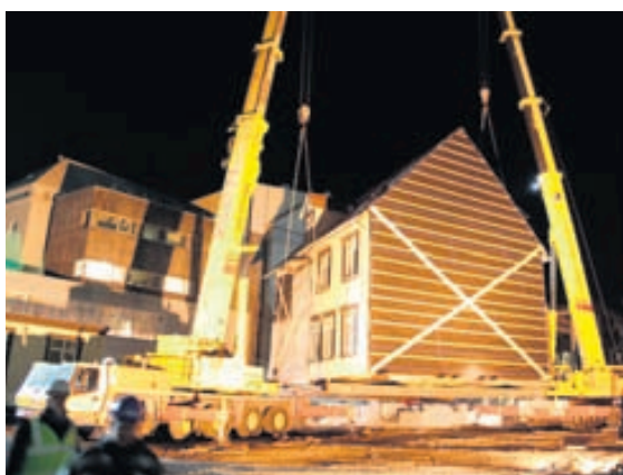
ÞRIGGJA KRANA TAK Aðalbyggingin á Vonarstræti 12 reyndist 50 prósentum þyngri en reiknað var með og því þurfti að bæta við þriðja krananum til að ráða við viðbótartonnin fjóru-tíu. MYND/BATTERÍIÐ ARKITEKTAR
