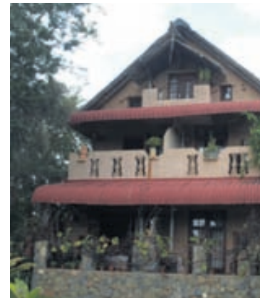
River House er gistihaus á besta stað við Kruger-þjóðgarðinn í Suður-Afríku.
