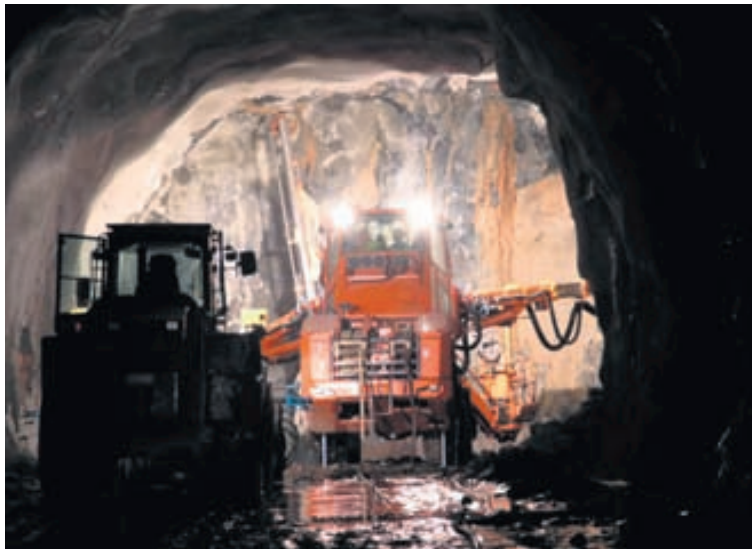
GANGAGERÐ Áætlað er að byggja níu kílómetra göng undir Vaðlaheiði. FÍB segir það langt frá því brýnustu vegaframkvæmdina og spyr hvernig galtómur ríkissjóður geti ábyrgt slíkt verkefni á meðan önnur mikilvægari stíji á hakanum. Myndin er frá Héðinsfjarðargöngum. MYND/VEGAGERÐIN
