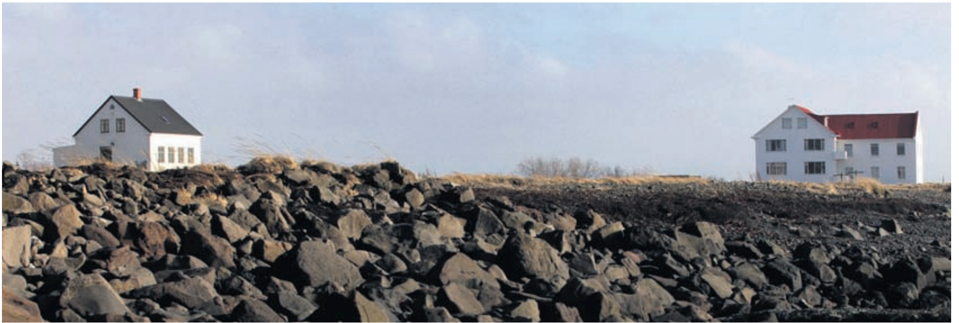
GARÐAR OG LAMBHÓLL Búið hefur verið í Görðum og á Lambhól síðan á nítjándu öld. Gamli bærinn á Lambhól var þó rifinn á þriðja áratugnum og byggt steinhús sem síðar var byggt við.
