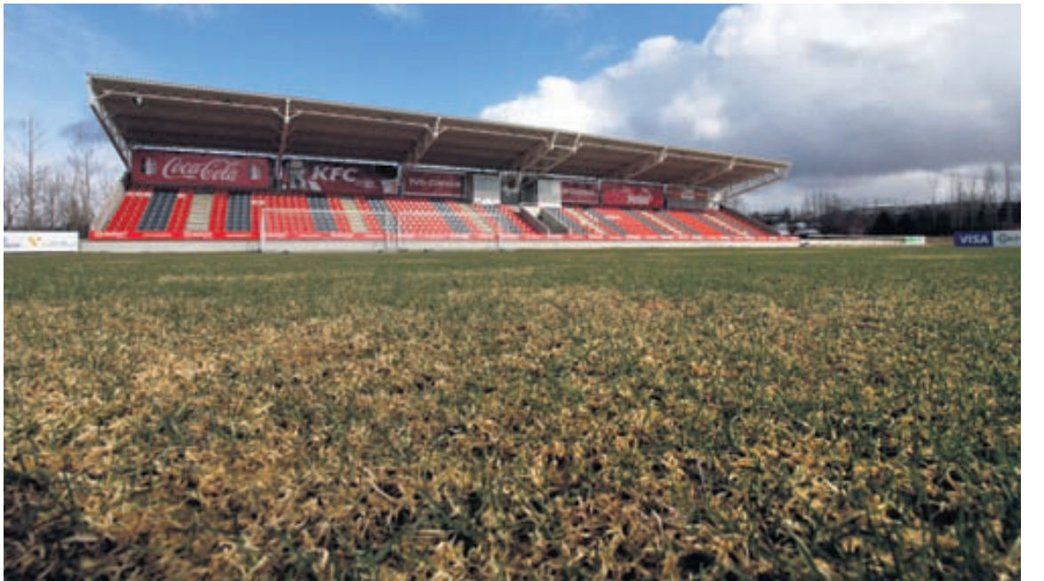
VÍKINGSVÖLLUR Ljósmyndari Fréttablaðsins kikti á Víkingsvöll í gær sem var ansi blautur eftir vætutið. Þar á bæ höfðu menn áhyggjur enda á leikur að fara þar fram á mánudaginn næsta.
