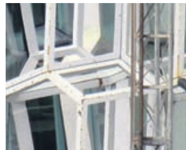
RYÐ Á KÖNTUM Myndin var tekin um miðjan apríl áður en glerhjúpur Hörpu var að fullu kominn upp. Nú hefur stálið verið sparslað og málað. MYND/ÓH
