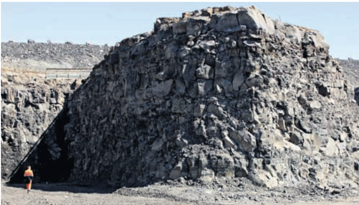
GRÖFUMADUR Í GLJÚFRINU Ekki væri vænlegt að vera undir þessu fjórtán metra háa bergi þegar þessi skarnhola verður tekin í notkun. Þessar framkvæmdir eru liður í baráttunni við fnykinn sem kemur af skarni eins og gori, slógi og seyru.
