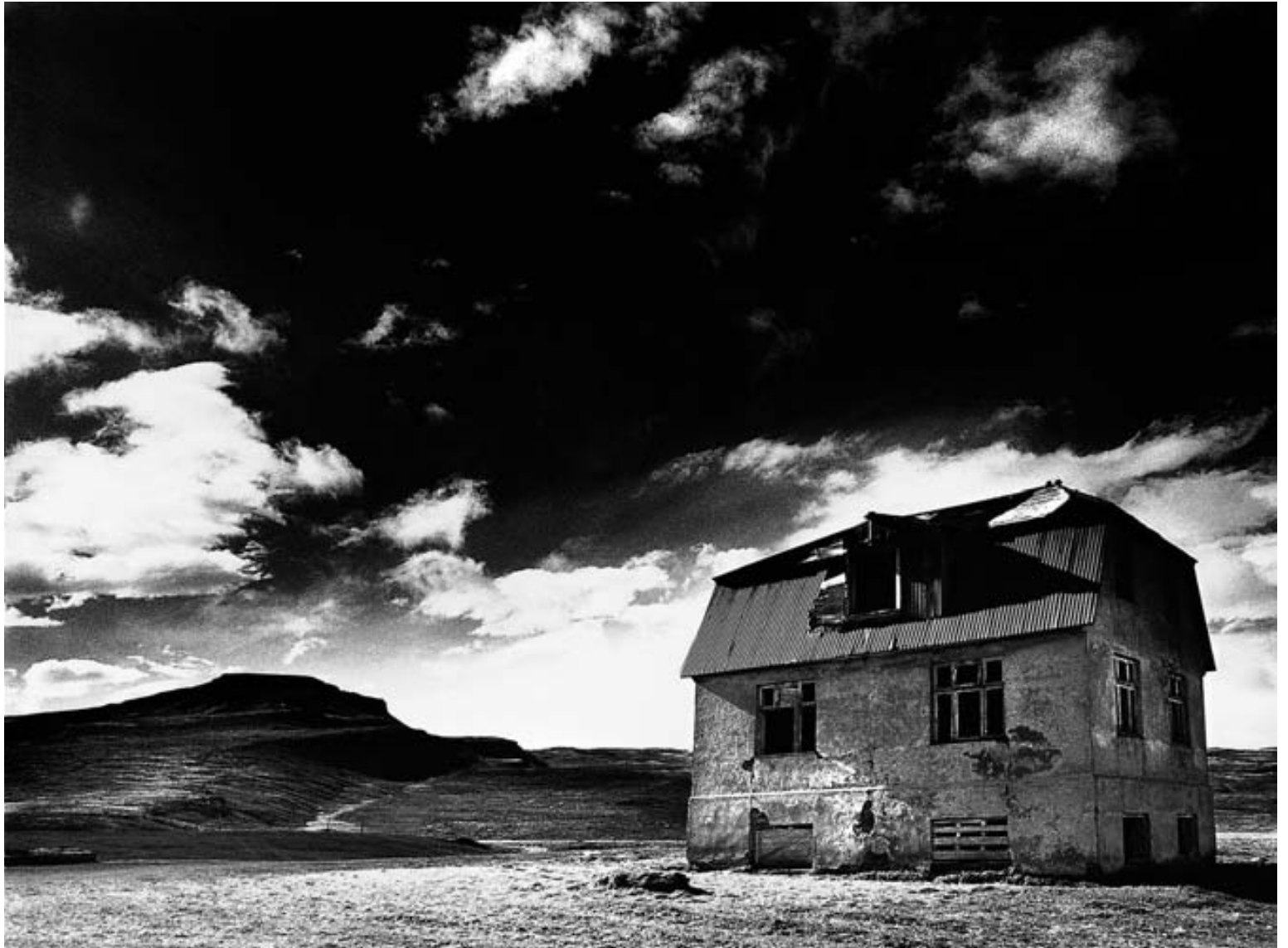
BRJÁNSLÆKUR Elstu myndirnar í bókinni eru frá 1985 en þær nýjustu voru teknar í fyrra. Mörg húsanna hafa verið jöfnuð við jörðu síðan þá og önnur gerð upp.
