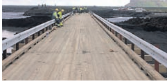
TÖRNINNI AÐ LJÚKA Vegagerðarmenn nýbúnir að hleypa vatni undir nýju brúna í gærkvöldi. MYND/GÍSLI BERG
