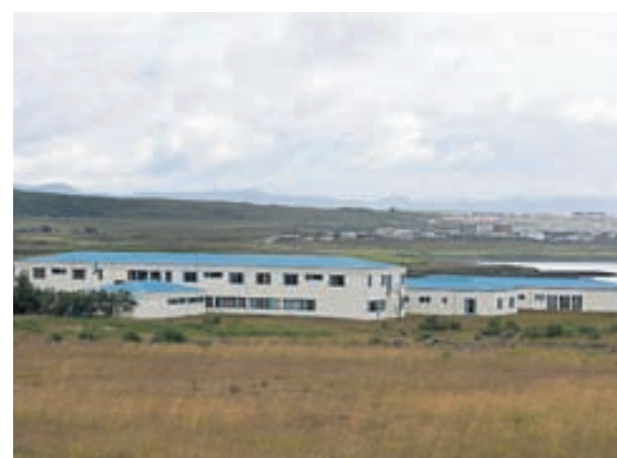
VÍÐINES Kostnaður við að breyta hjúkrunarheimilinu á Víðinesi í fangelsi er svipaður og við það að byggja nýtt.
