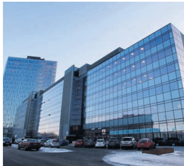
HÖFÐATORG Félagið sem stofnað var utan um bygginguna skuldaði tæpa 22 milljarða króna í árslok 2009.
