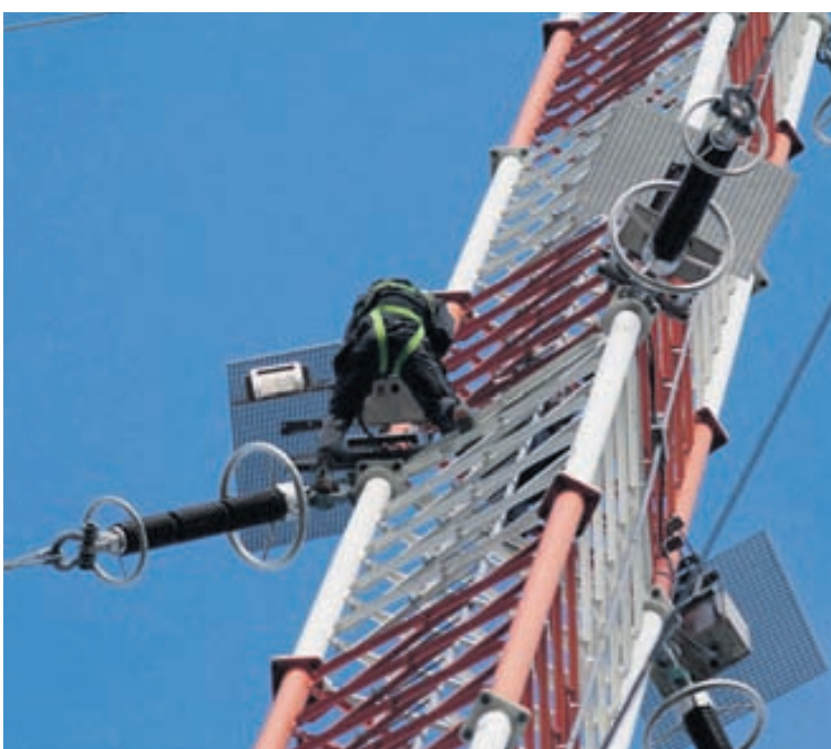
UNNIÐ Í MASTRINU Það er ekki heiglum hent að klífa 220 metra hátt mastrið og hanga utan á því til að gera við hin síbilandi leifturljós sem vara eiga flugmenn við mastri.
